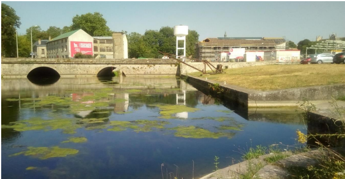
Fig.1 : vue de l'emprise des travaux
